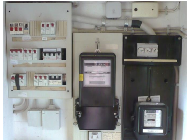
Abb. 25: Beispiel für einen relativ alten Stromkreisverteiler
