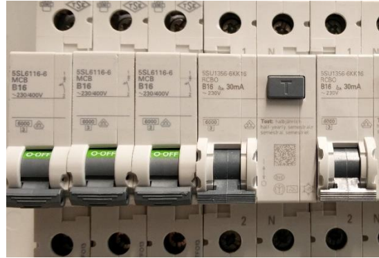
Abb. 3: Sicherungen in einem Stromkreisverteiler
