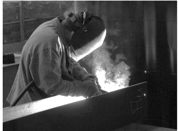
Bild 5-4: Einschweißen der eingepassten Quersteifen in Wannennlage
