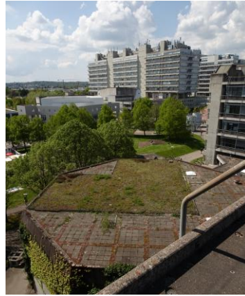
Dach des Hörsaals V 7.02
