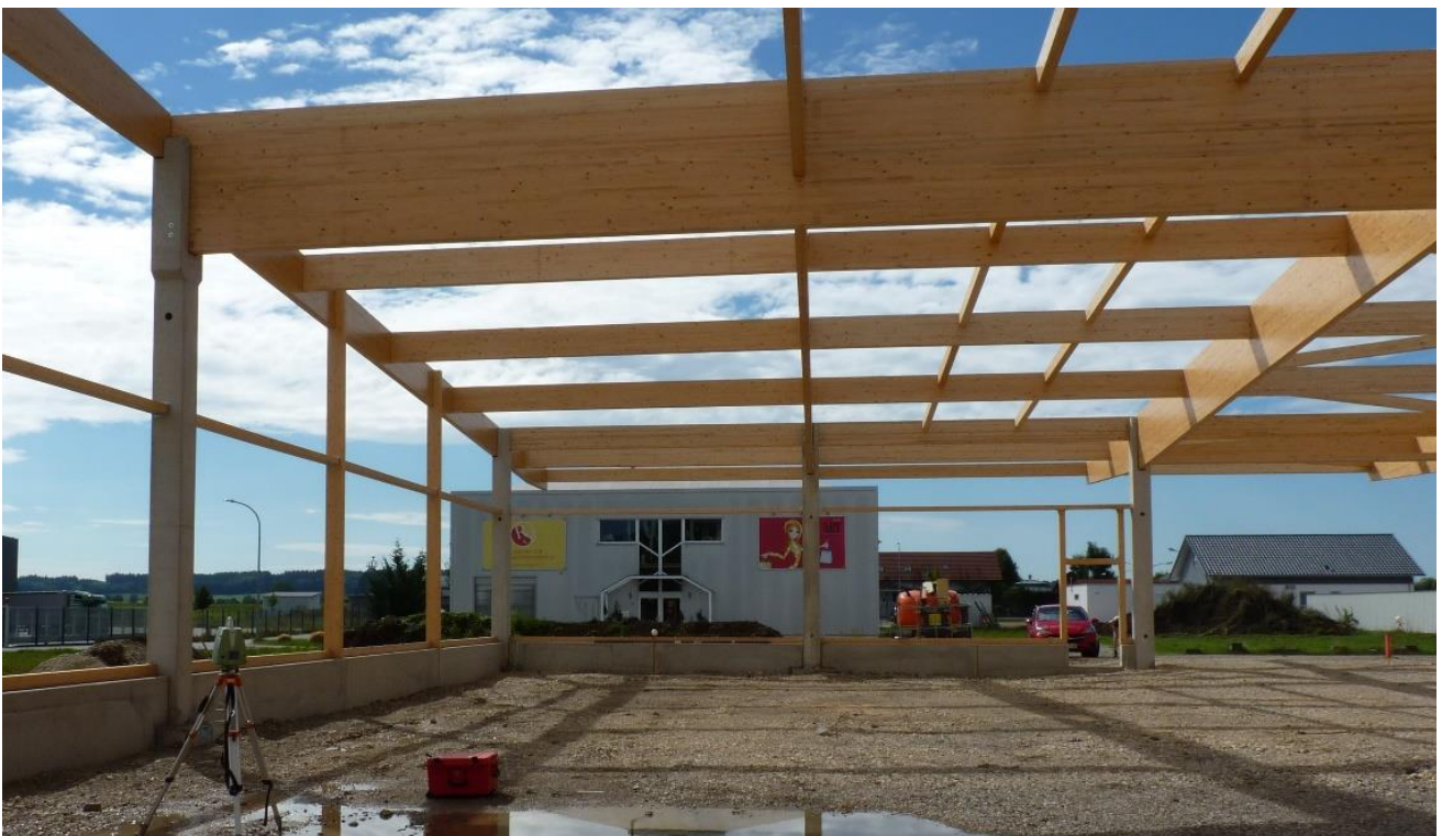
Abb. 3: Aufbau Laserscanner, Bauvorhaben 2020-KW34.
