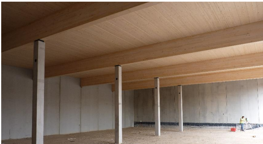
Abb. 68: Bauvorhaben 2020-KW38_1.3 zum Zeitpunkt der Messung
