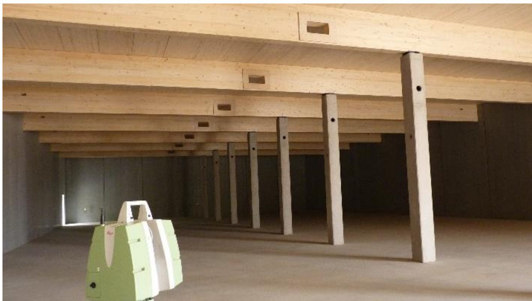
Abb. 62: Bauvorhaben 2020-KW38_1.2 zum Zeitpunkt der Messung
