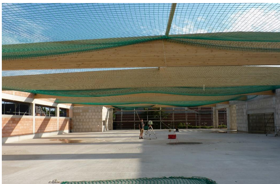
Abb. 108: Bauvorhaben 2021-KW30_2 zum Zeitpunkt der Messung
