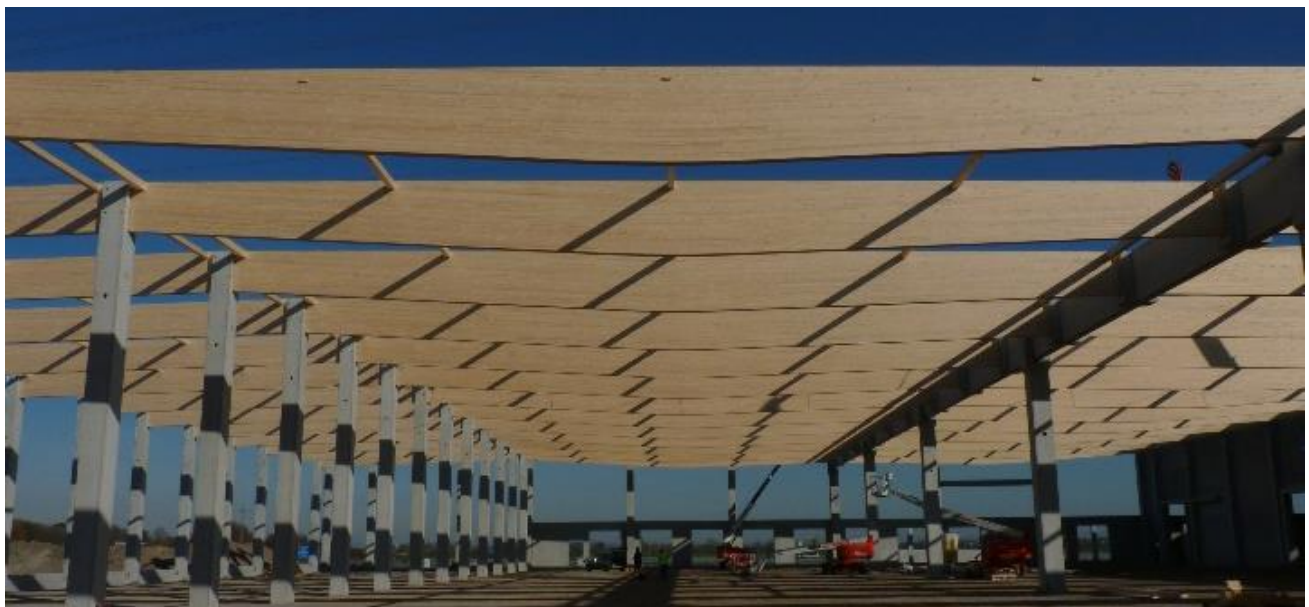
Abb. 81: Bauvorhaben 2020-KW45_1.2 zum Zeitpunkt der Messung
