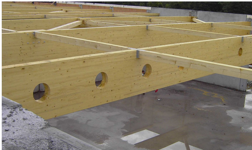
Abbildung 7.32: Ausgeführte Hallenkonstruktion mit Brettschichtholzbindern und Aussteifungsverbänden
