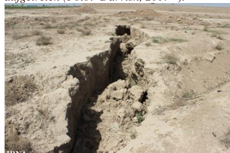
Abbildung 4-46: Varamin-Ebene in West-Teheran. Geländesenken und Erdfälle, infolge der Wasservabsenkung (Foto: IRNA 86 ).
