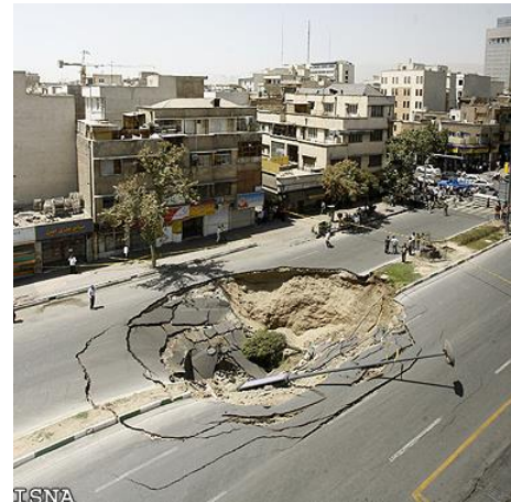
Abbildung 4-43: Senkung in der Navab-Autobahn im August 2009 in Teheran, dabei gab es einen Toten und vier Verletzte. Suffosion kann für Städte mit vielen Gebäuden hochgefährlich sein (Foto: ISNA 83 )
