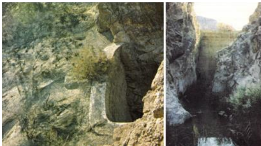
Abbildung 1-15: Tang-e-Mahi, ein großer 700 Jahre alter Staudamm mit der Höhe von 21 Metern. Er wurde zu Verhinderung der Wasserverdunstung und Reduktion des Salzgehalts des Wassers durch den salzhaltigen Boden gebaut und wird mit Sand durch eine spezielle Drainage befüllt und behandeltes, gereinigtes Wasser kommt heraus. Auf dem oberen Teil des Dammes sieht man statt Wasser eine Strauch-Landschaft. Die Menge des ausgegebenen Wassers beträgt 32-82 L/Sec. (Jawaheri & Jawaheri, 1999: 20&43)
