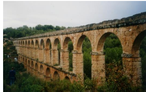
Abbildung 1-13: Aqüeducte de les Ferreres bei Tarragona, Spanien 13
