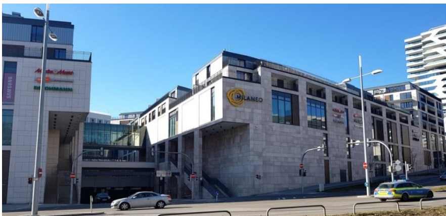
Abbildung 14: Milaneo, Ansicht Wolframstraße, Foto Verfasser
