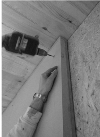
Figure B3-4. Straw carton panels fixation possibilities on hidden stud boards, (Technisches Vertriebsbüro Burgstaller).
