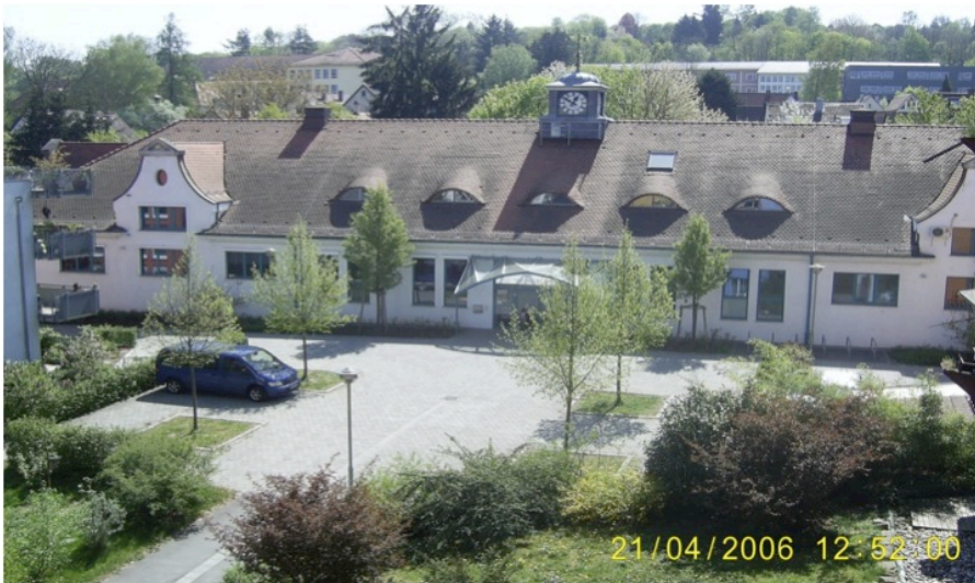
Abb. 4-21 Große Halle [Oben] (eigenes Foto 2013)
