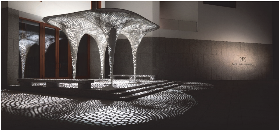
Abbildung 2-13: Topologisch optimierte Schalenstruktur aus faserverstärktem Beton
