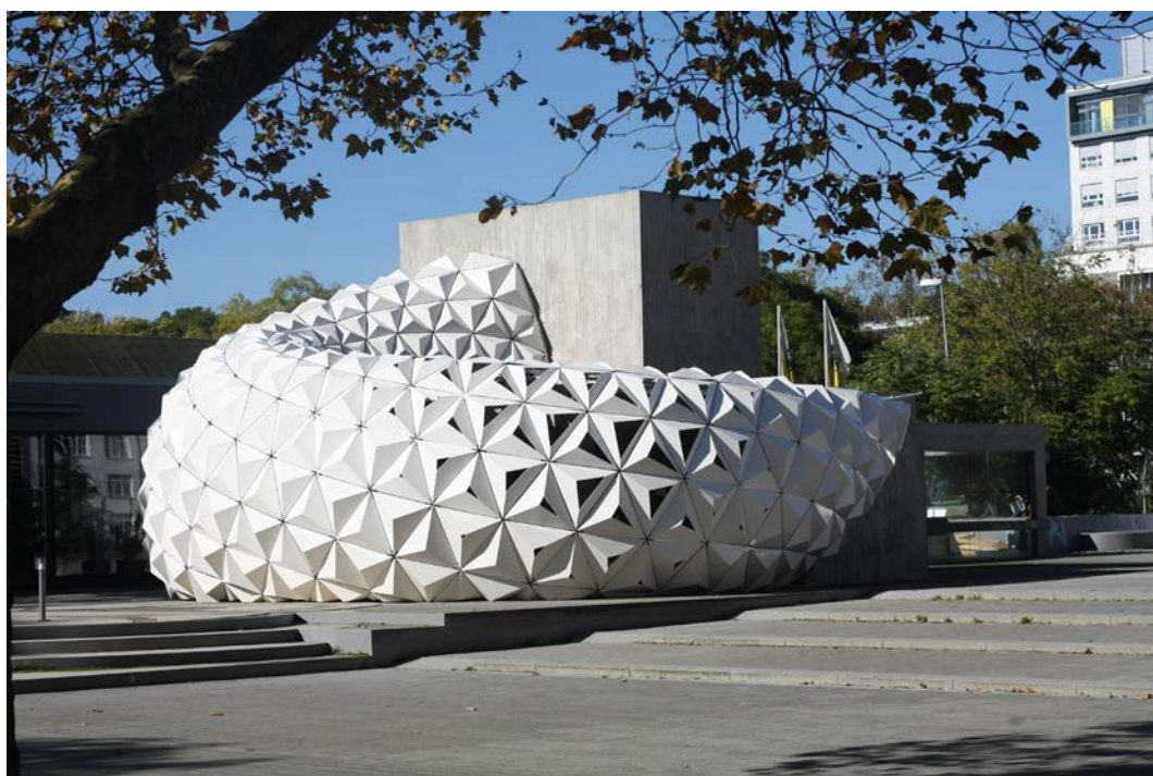
Abb. 122 Fassaden-Mock-Up ArboSkin aus Biokunststoffen Bild © Manfred R. Hammer/ ITKE
