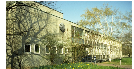
Ehemaliges Institutsgebäude in der Breitscheidstraße 2b
