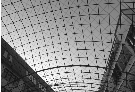
Figure 1.3.: Translational grid shell with quadrangular mesh, Bosch-Areal, Stuttgart (Arch.: Prof. Ostertag + Vornholdt; Eng.: Schlaich, Bergermann und Partner).
