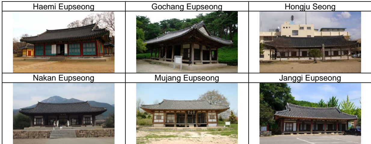
Abb. 2-15: Die Verwaltungsgebäude Dongheon von Eupseong aufgenommen als der nationale historische Ort 1061
