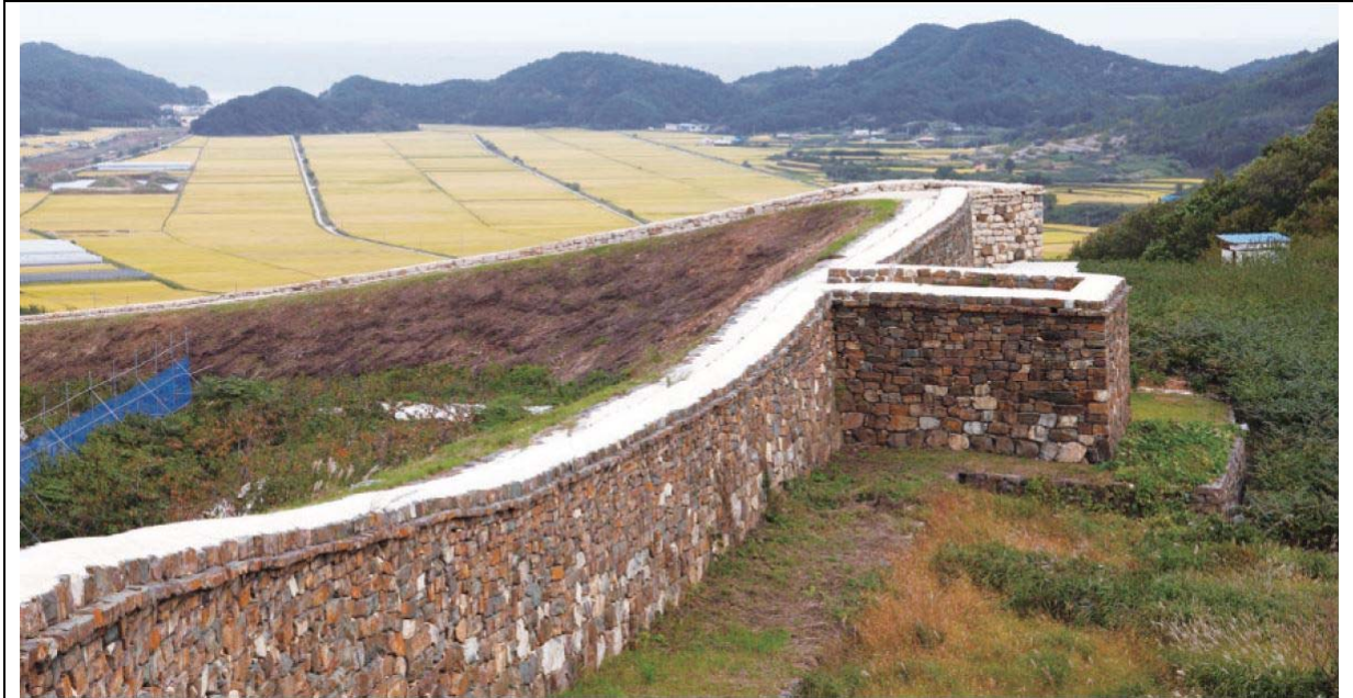
Abb. 3-48: Eine Bastion 1115 der Stadtmauer 1116
