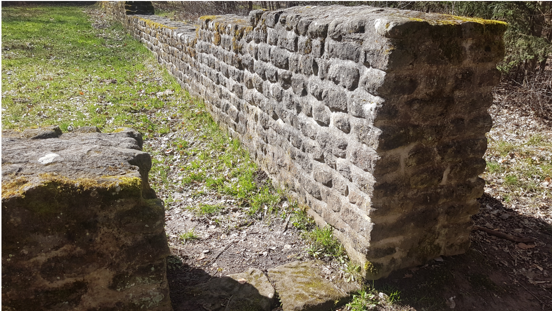
(a) Reales Aussehen des betreffenden Mauerabschnitts.
