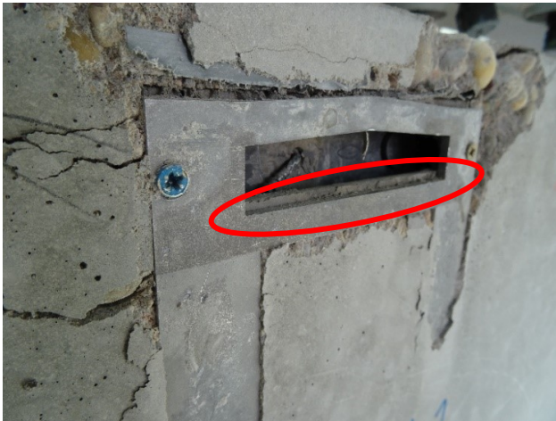
Abbildung 4.20: Versagensbild der durch ein aufliegendes Verstärkungsmodul verstärkten Ankerschiene mit separater Verschiebung der Ankerschiene (roter Kreis).
