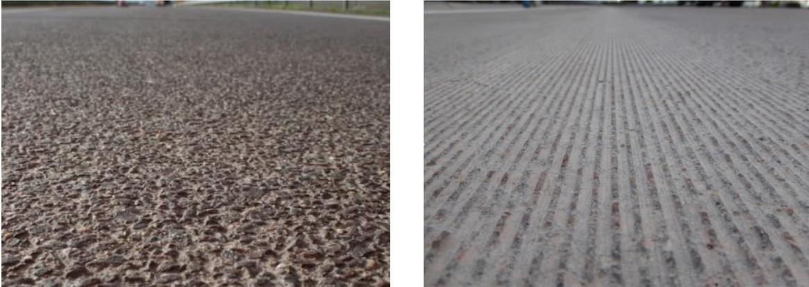
Abbildung 2.28: Exemplarische Darstellung der Fahrbahnoberfläche einer Betondecke mit Waschbetontextur (links) und Grindingtextur Typ S (rechts) [54]
