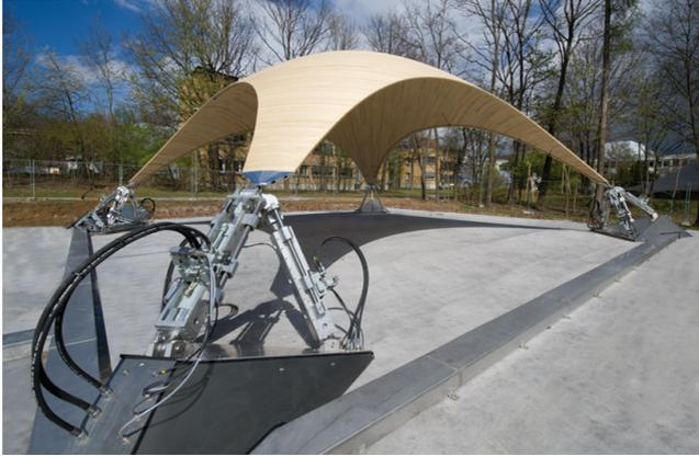
**Abbildung 1.3:** Stuttgart SmartShell: doppelgekrümmtes adaptives Schalenträgerwerk [96].
