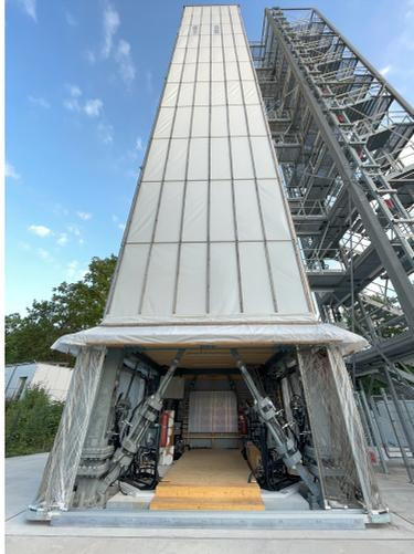
**Abbildung 2.1:** Das experimentelle adaptive Hochhaus D1244, erbaut an der Universität Stuttgart, mit Zugangsturm auf der rechten Seite.
