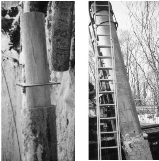
Abb. 2: angefräster Stamm (links), Aufrahmen der Stahlhülse (rechts) [2]
