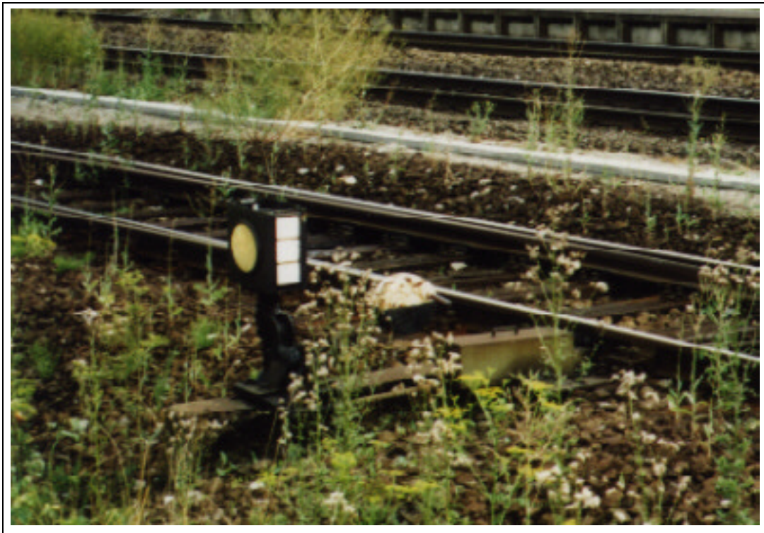
Manuell zu betätigende Handweiche am Bahnhof Oberdachstetten.
