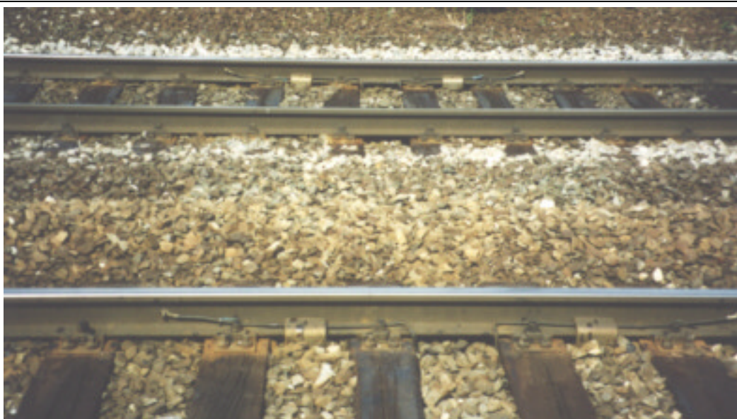
Einleitung eines Gleisstromkreises am Bahnhof Oberdachstetten
