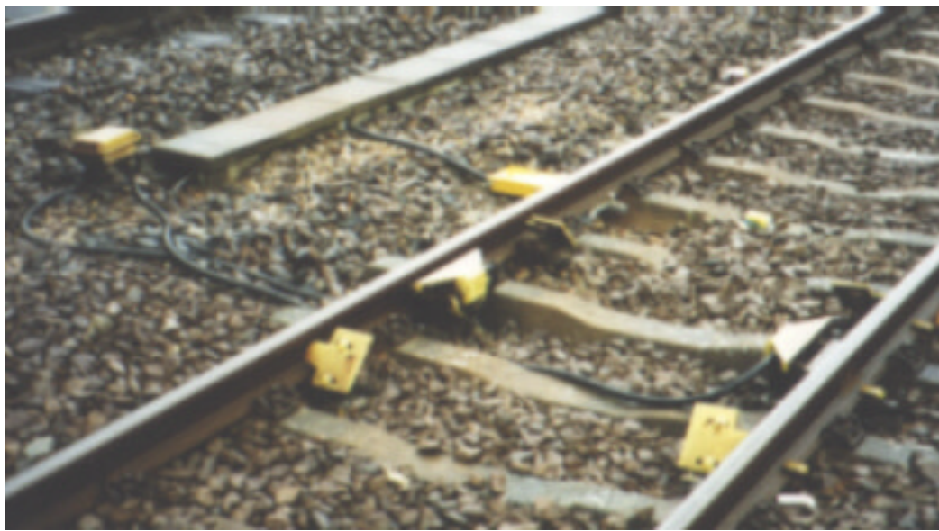
Achsanzahlanlage am Bahnhof Lauffen / Neckar
