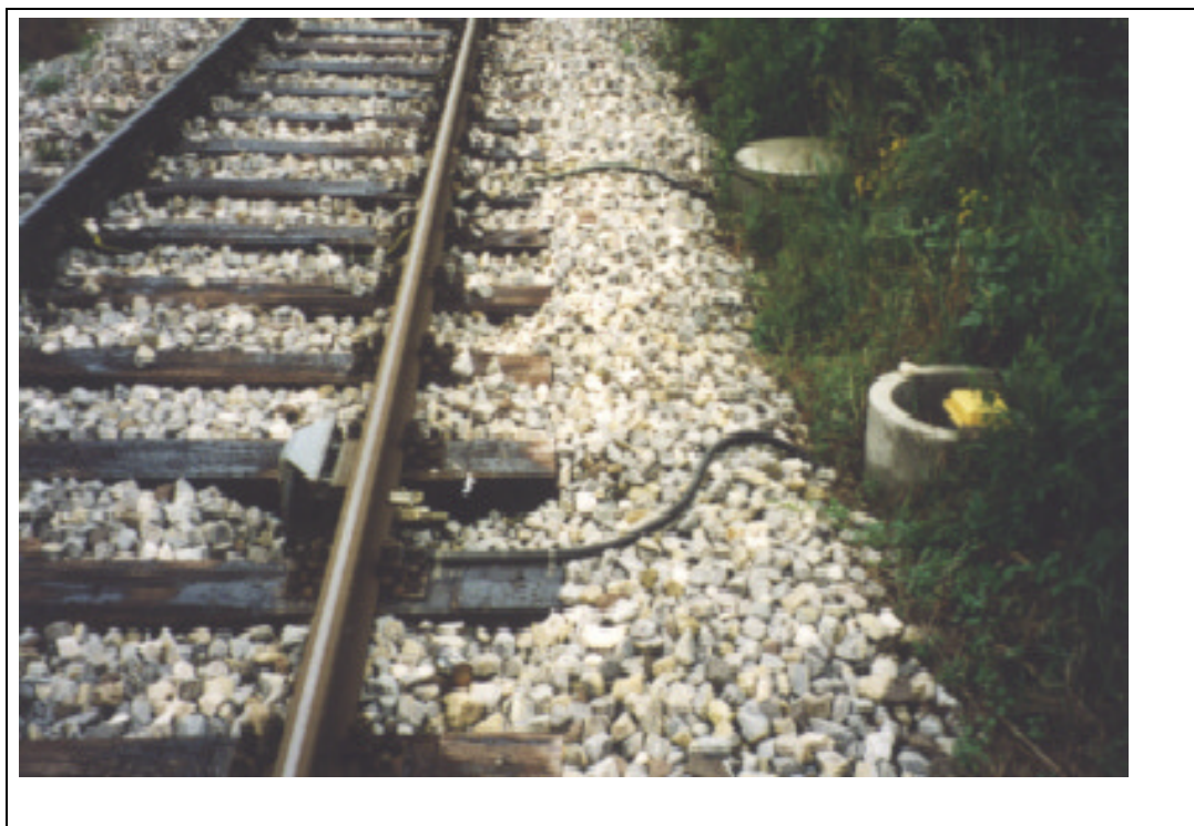
Gleissensor zur Auslösung aller möglichen Steuerbefehle im Bahnbetrieb
