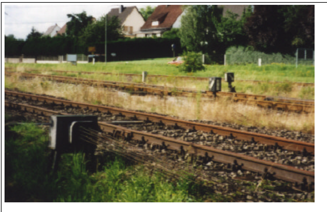
Drahtverbindung zur Weichensteuerung von einem mechanischen Stellwerk an der Lautertalbahn
