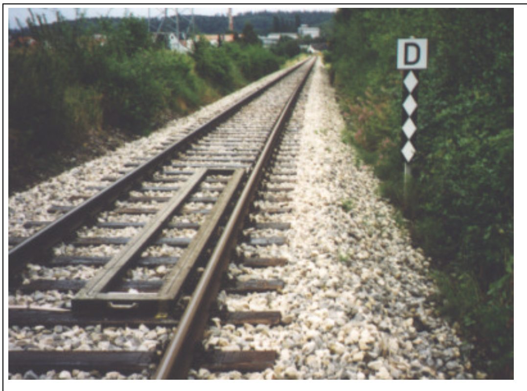
Leiterschleife als BÜ-Einschaltpunkt an der Schönbuchbahn
