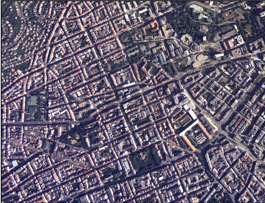
Abbildung 2-20: Siedlungstyp 7b – Dichte Blockbebauung
