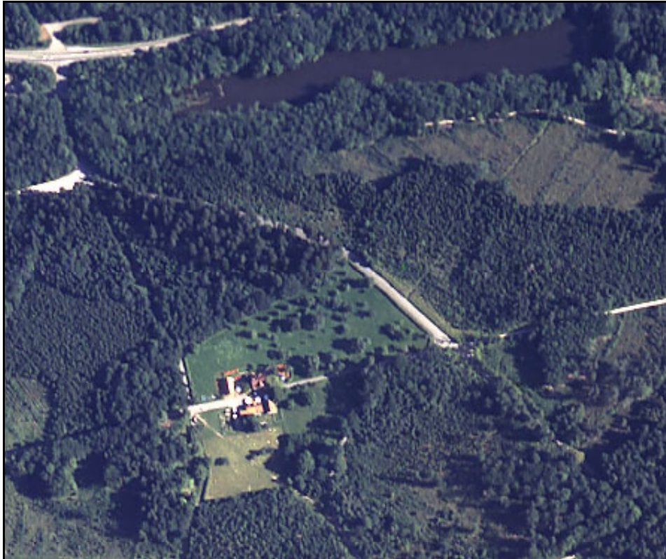
Abbildung 2-1: Siedlungstyp 0 – Freistehende Gebäude
