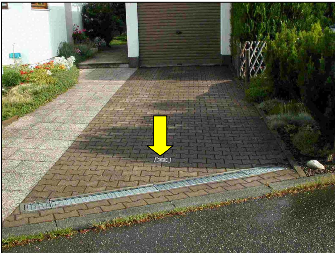
Abbildung 57: Lage des Referenzpunktes für die Positions- und Höhenbestimmung
