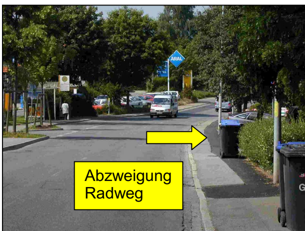
Abbildung 68: unübersichtliche Abzweigung durch fehlende Beschilderung
