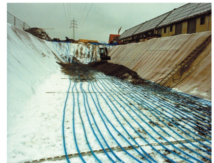
Abb. 22: Aufbau des Kies/Wasser-Wärmespeichers (1500 Kubikmeter) in Steinfurt-Borghorst.
