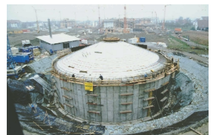
Abb. 21: Heißwasser-Wärmespeicher (12 000 Kubikmeter) während der Bauphase (Friedrichshafen).
