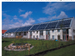
Rostock-Brinkmannshöhe (1999) 108 Wohnungen, 1000 m 2 Flachkollektor, 20.000 m 3 Aquifer-Wärmespeicher
