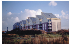
Hannover-Kronsberg (2000) 106 Wohnungen, 1350 m 2 Flachkollektor 2750 m 3 Heißwasser-Wärmespeicher
