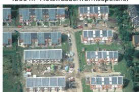
Neckarsulm-Amorbach (1998) 2850 m 2 Flachkollektor, 20.000 m 3 Erdsonden- Wärmespeicher
