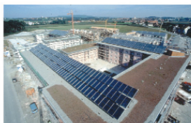
Hamburg-Bramfeld (1996) 124 Reihenhäuser, 3000 m 2 Flachkollektor, 4500 m 3 Heißwasserwärmespeicher
