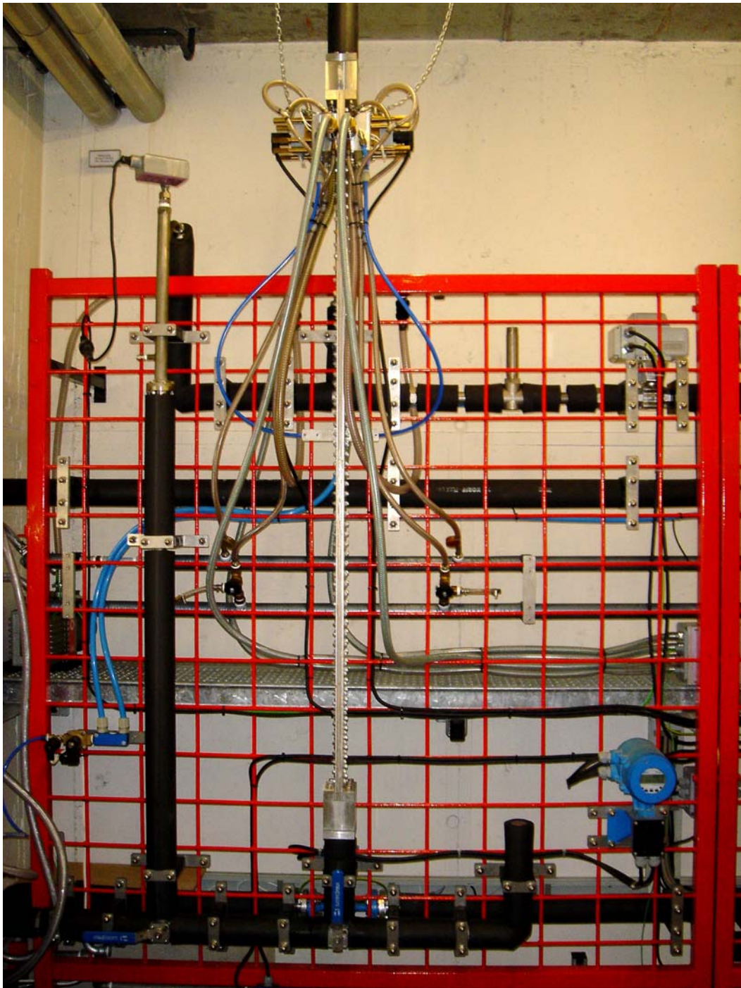
Abbildung 3.2: Linke Versuchsmessstrecke in eingebautem Zustand
