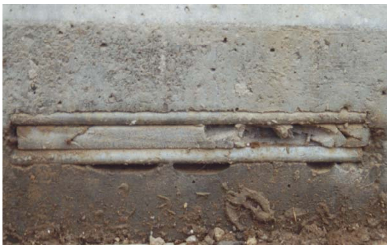
Bild 10.6: Horizontaler Einbau einer Schiene mit geringem Randabstand
