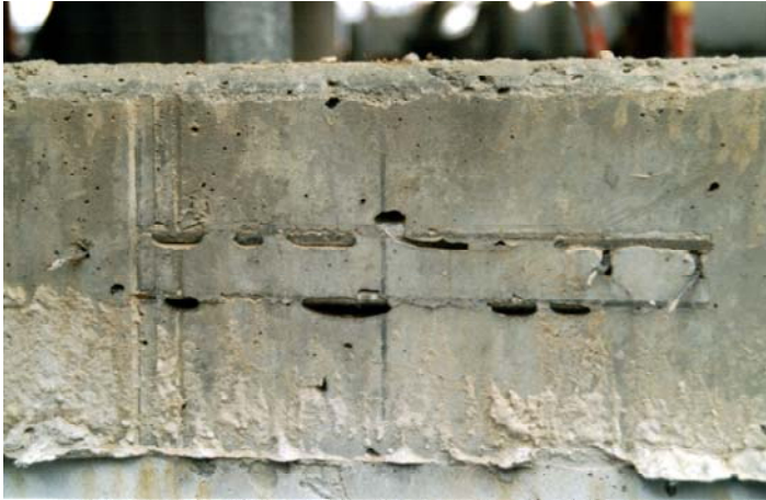
Bild 8.5: Wasser und Lufteinschlüsse unter Ankerschienen
