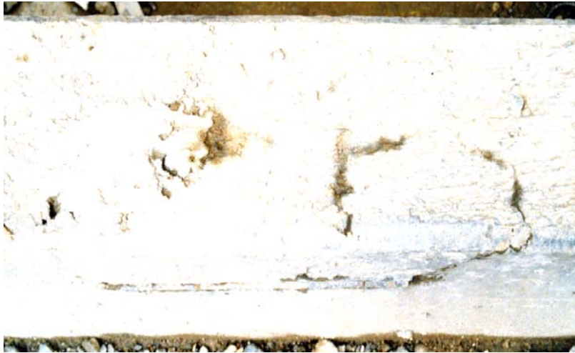
Bild 10.12: Versuch einer Korrektur durch Aufbringen von Mörtel
