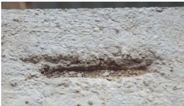
Bild 10.2: Von oben eingebaute Schiene 40/25 mit zu tiefer Einbauposition
