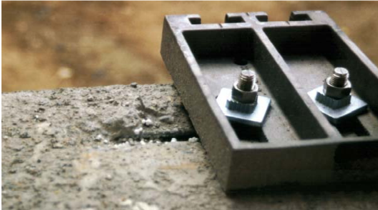
Bild 10.3: Fertig montierte Fassadenbefestigung an der Schiene aus Bild 10.2
