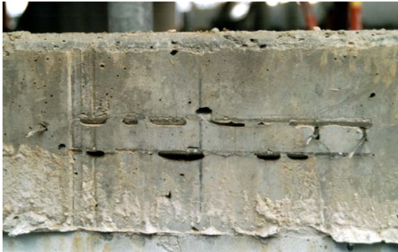
Bild 10.7: Horizontaler Einbau einer Schiene in einem schmalen Bauteil
