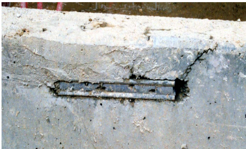
Bild 10.11: Ausbruch einer Ankerschiene durch falsches Entfernen der Schalung
