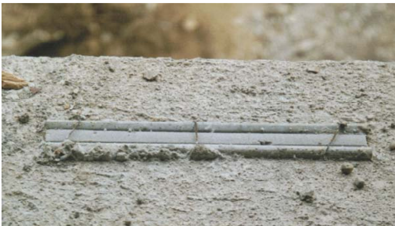
Bild 10.4: Von oben eingebaute Schiene 40/25 mit zu hoher Einbauposition
