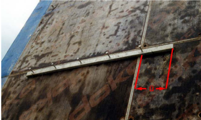
Bild 10.10: Fehlender Endanker
