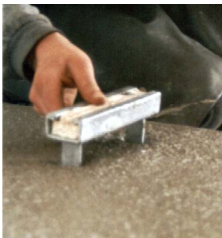
Bild 10.8: Einbau einer Ankerschiene von Hand ohne Nachverdichtung und Fixierung
