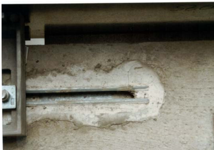
Bild 10.13: Ankerschiene eingebaut mit Quellmörtel
