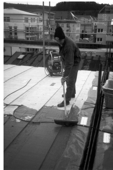
Abbildung 6.16: Aufbringen der Zementschlempe
