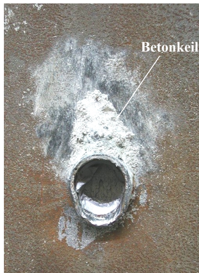
Bild 8-8. Anriß zwischen Schweißwulst und Dübel – Versagenstyp A mit Betonkeil
