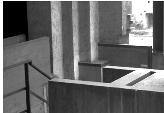
Abb. 253: Raum des Cangrande OG, Abtreppung der Außenmauer
