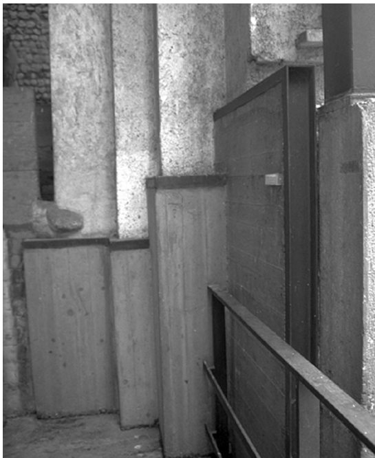
Abb. 249: Vorgelagerte Betonwand Abb. 250: Betontreppe des Wehrganges Abb. 251: Dachuntersicht, Raum des Cangrande Abb. 252: Holzpaneele vor der Fassade
