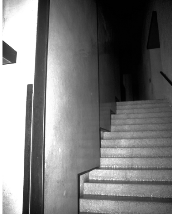
Abb. 274: Caserma, Paneele im Treppenabgang zum Erdgeschoß
