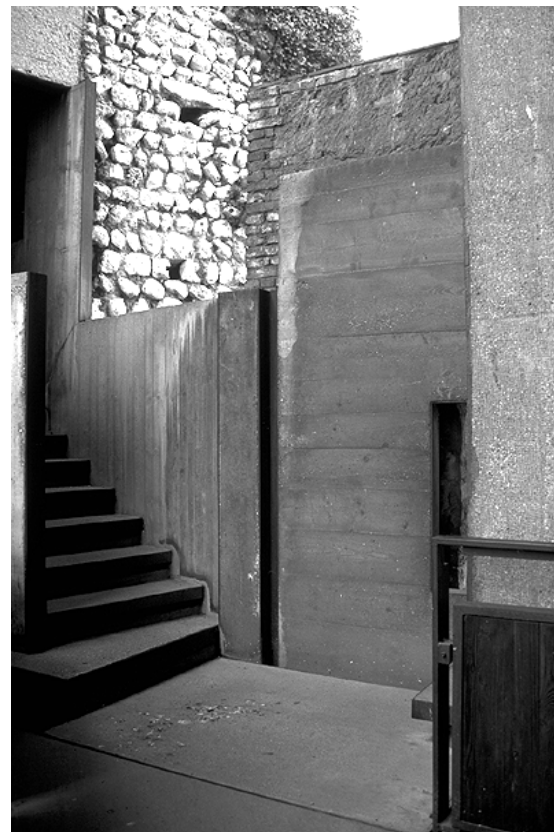
Abb. 248: Betonauskleidung im Bereich des Cangrande
