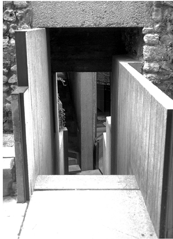
Abb. 248: Betonauskleidung im Bereich des Cangrande
