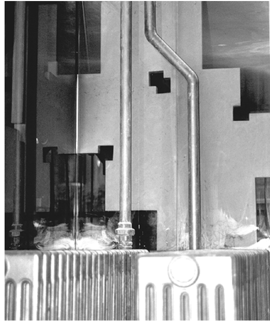
Abb. 303: Heizkörperverkleidung von innen
