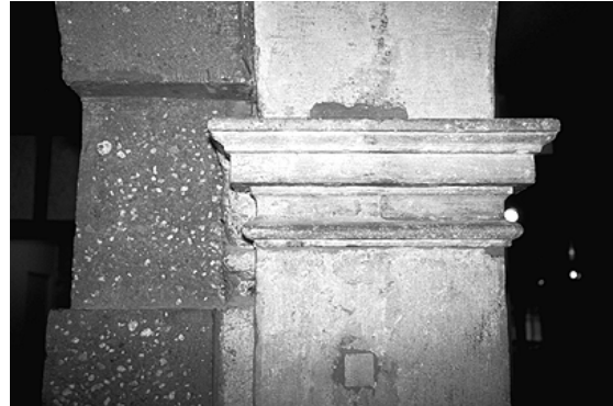
Abb. 289: Tor mit Betonvorlage, Detail
