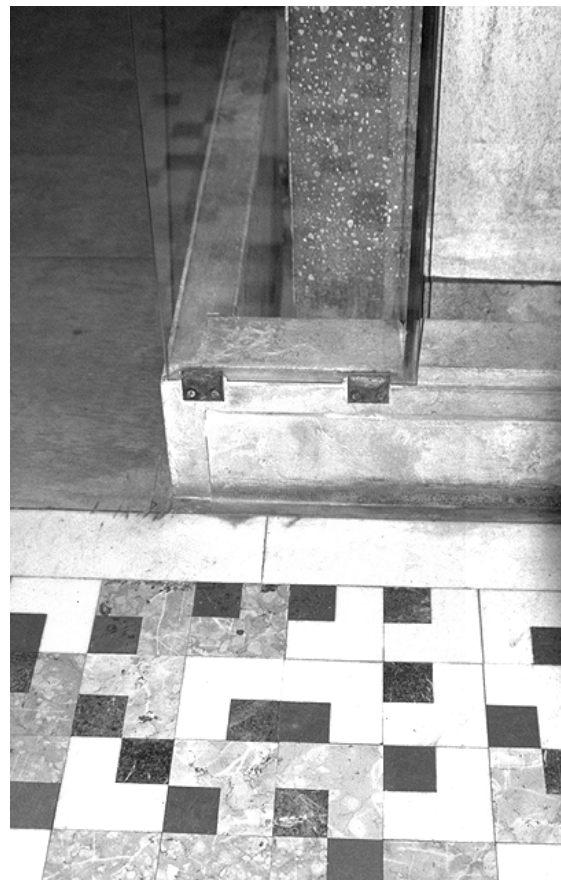
Abb. 284: Eingangsbereich, Detail Betonaufkantung
