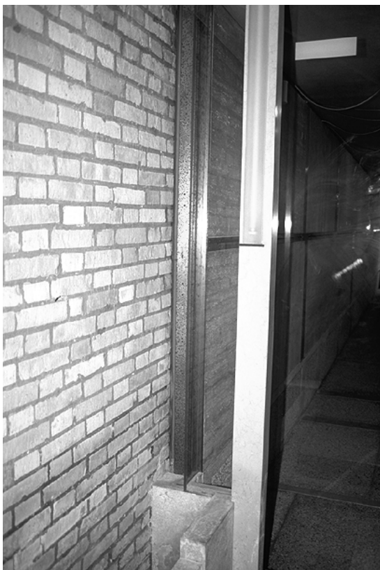
Abb. 302: Übergang Glaswand-Ziegelwand
