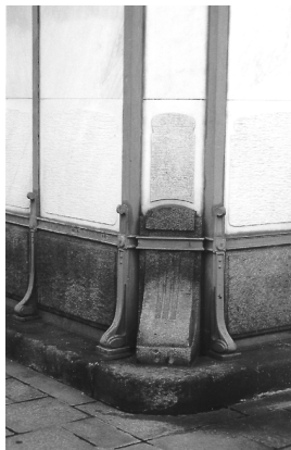
Abb. 81: Otto Wagner: Straßenbahnstation Karlsplatz, Wien, 1894: Stahlkonstruktion mit Ausfachungen Abb. 82: Carlo Scarpa: Venezuela Pavillon, Venedig, 1954-1956, Stützendetail
