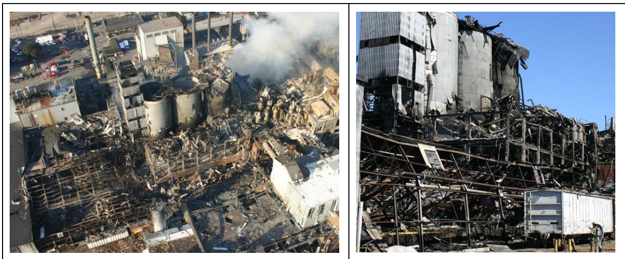
Abb. 30. Imperial Sugar Raffinerie in Port Wentworth, Georgia, USA, nach den Zuckerstaubexplosionen und Folgebränden vom 7. Februar 2008. Aus [CSB 2009].
