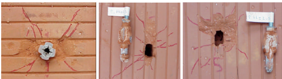
Bild 10.20: Steinschädigungen in Hlz12 nach zentrischen Ausziehversuchen mit einem Versuchsaufbau nach Bild 10.6
