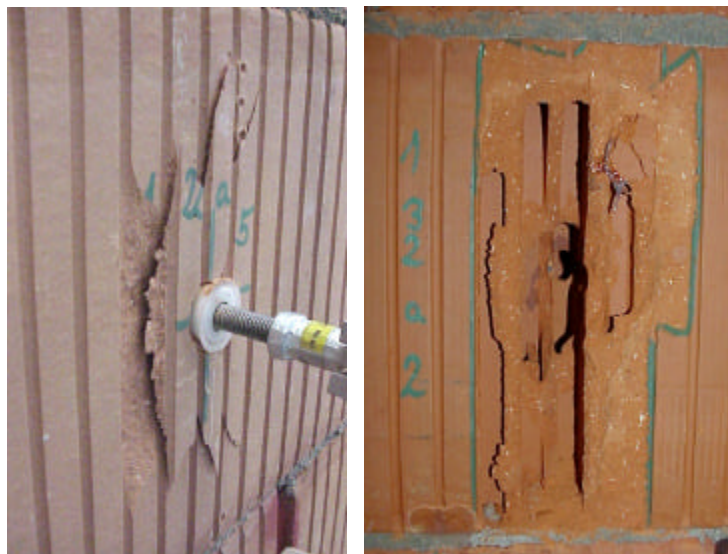
Bild 5.6: Versagensbilder im Mauerwerkverband bei zentrischen Ausziehversuchen
