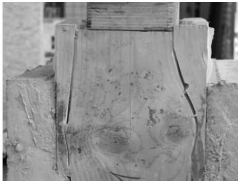
Bild 2.11: Fehlstellen im Kervenbereich
