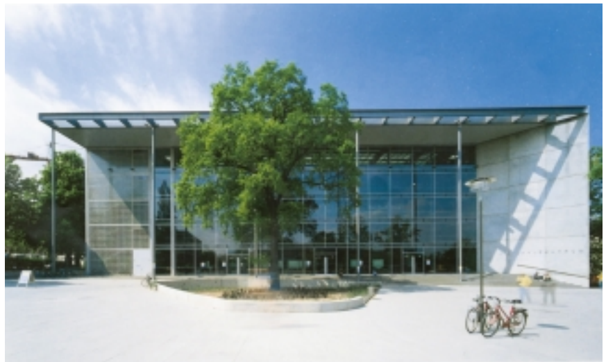
Neubau des Hörsaalzentrums mit kleinem Vorplatz an der Bergstraße. Ansichten von der Bergstraße und von der grünen Hochschulmitte. Architekten: Klein + Sängler, Dömges & Partner, München/Regensburg; Landschaftsarchitekten Burger + Tischer, Berlin.
