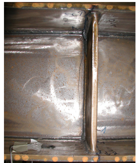
Bild 6.55: Durchriss an den Flanschen und Rissfortschritt in den Steg (PK2)
