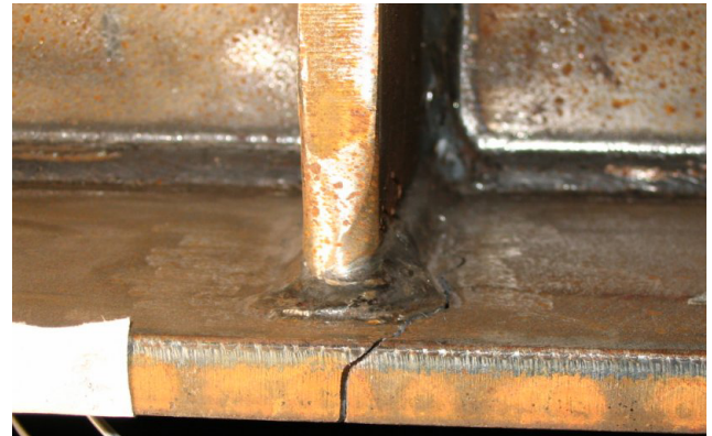
Bild 6.61: Durchriss am Zuggurt im Bereich der Quersteife (PK5)
