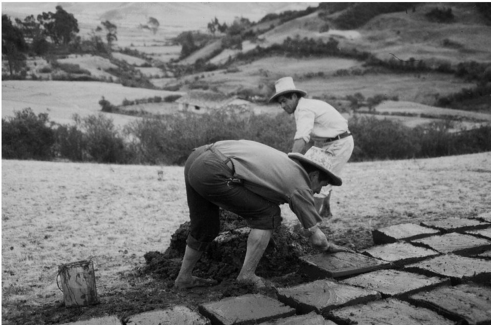
Bild 6: Gemeinschaftsarbeit, Herstellung von Adobes für eine Windmühle
