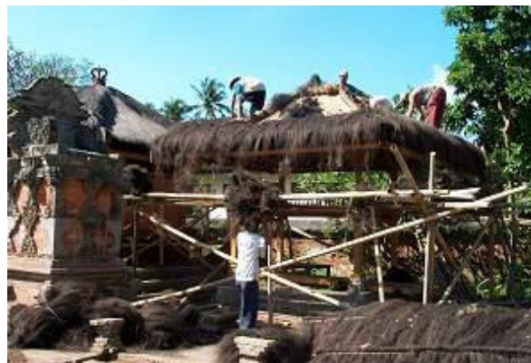
Bild 4.4. Gotong Royong bei der Errichtung eines Gebäudes
