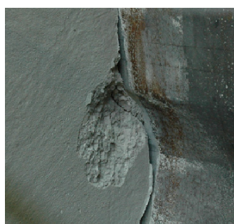
Abb. 4.13: Abplatzungen an den Faltungskanten
