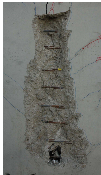
Abb. 4.14: Abplatzungen auf der Außenseite weit im Nachbruchbereich
