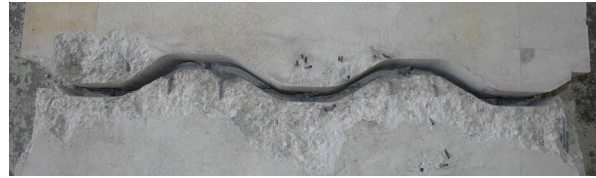
Abb. 4.45: Versagen der unteren Abstützstelle beim BD-Q2
