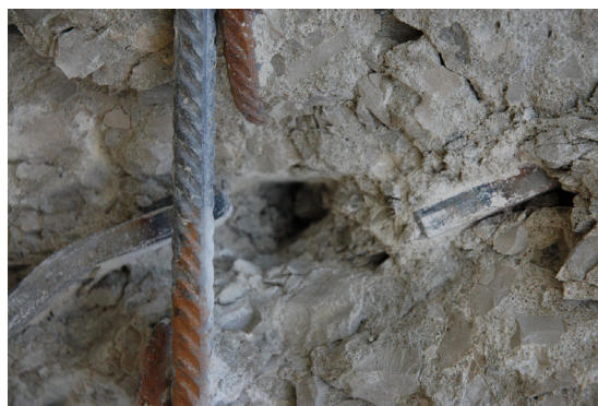
Abb. 4.15: Verwindung der Stegaussparung infolge der Faltung
