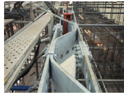
Abb. 2.27: Verbundfuge der Kurobegawa-Brücke [SAITO, K., ET. AL. (2002)]
