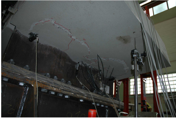
Abb. 4.44: Betonausbruch bei Körper BD-Q1 nach Überschreiten der Maximallast
