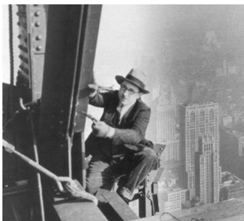
Abbildung 1.1: Überwachung am Bauwerk, links: „Visiting inspector“, Klangprüfung einer Nietverbindung im Stahlbau um 1930 [Hine 1998], rechts: Impact-Echo-Prüfung an einer Spannbetonbrücke 2004.
