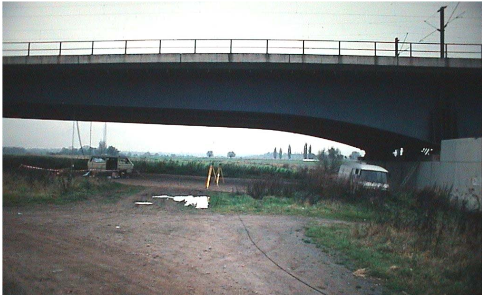
Abbildung 7.12: Bild der Kontrollkamera und Standpunkt des Theodolits
