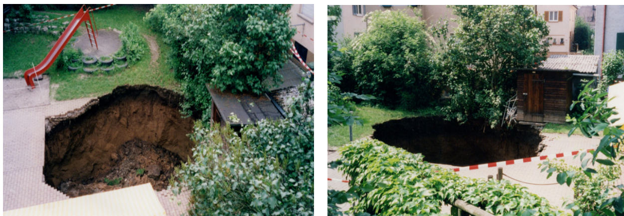
Abbildung 6.2: Erdfall Ihmlingstraße vom Mai 2000 (Durchmesser 6 m).
