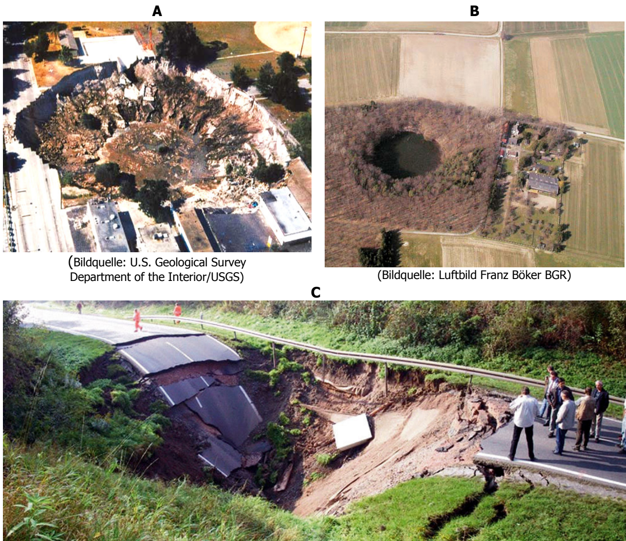
Abbildung 1.1: A) Winter Park Sinkhole, U.S. Bundesstaat Florida vom Mai 1981, B) Erdfall Dillsgraben bei Bockenem, Niedersachsen (BÜCHNER 2003) und C) Erdfall an der Bundesstraße 180 bei Eisleben, Sachsen-Anhalt (HEROLD & HECKNER 2001).
