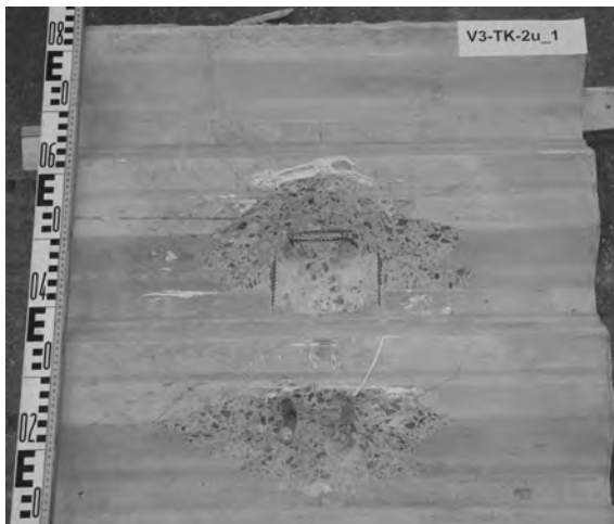
Innenansicht des Betongurts Seite 1 bei V3-TK-2u
