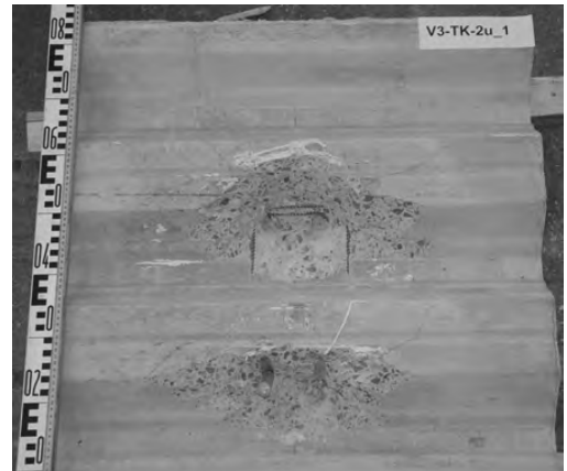
Bild 5.14: Innenansicht Betongurt V3-TK-2u
