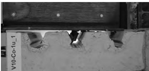
Betonausbruch bei V10-Co-1u Seite 1
