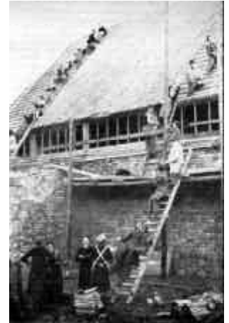
2 Gemeindeglieder beim Bau der Notkirche des HEKD (Offenbarungskirche) in Berlin.
