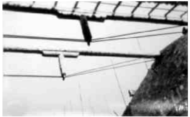
57 Unterspannte Dachkonstruktion in der Scheunenkirche in Boust. Foto von Steffann aus seiner "Baufibel für Lothringen".
