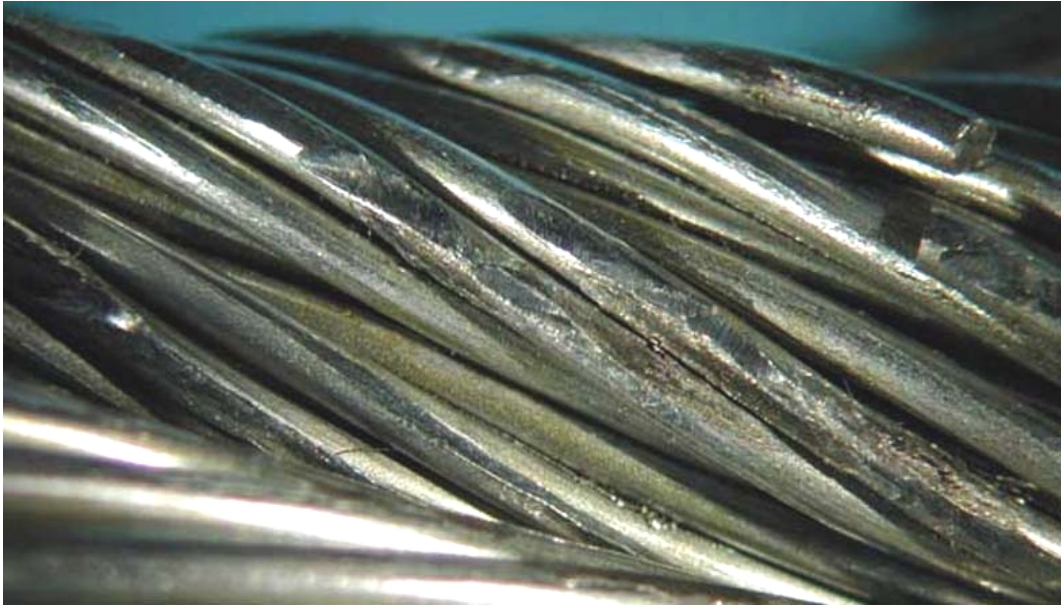
Bild 4.40: Zwölffache Vergrößerung der geschädigten Seileinlage (Seil C)
