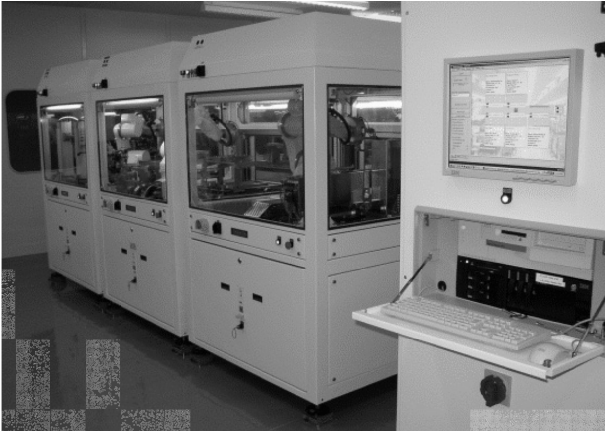
Abb. 6.4: Komplette Montageanlage mit drei Montagezellen und Leitstand der Montageanlage (© IBM Corporation)
