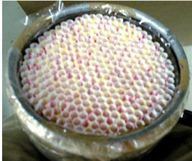
Bild 6.4: Gleichrichter im Rohrkrümmer
