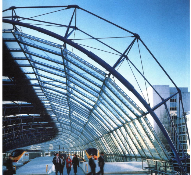
Abbildung 2-3: Beispiele für eine innenliegende Tragwerkskonstruktion (linkes Bild, Louvre-Pyramide in Paris) und eine außenliegende Tragwerkskonstruktion (rechtes Bild, Waterloo International Terminal) (Wigginton, 1997)
