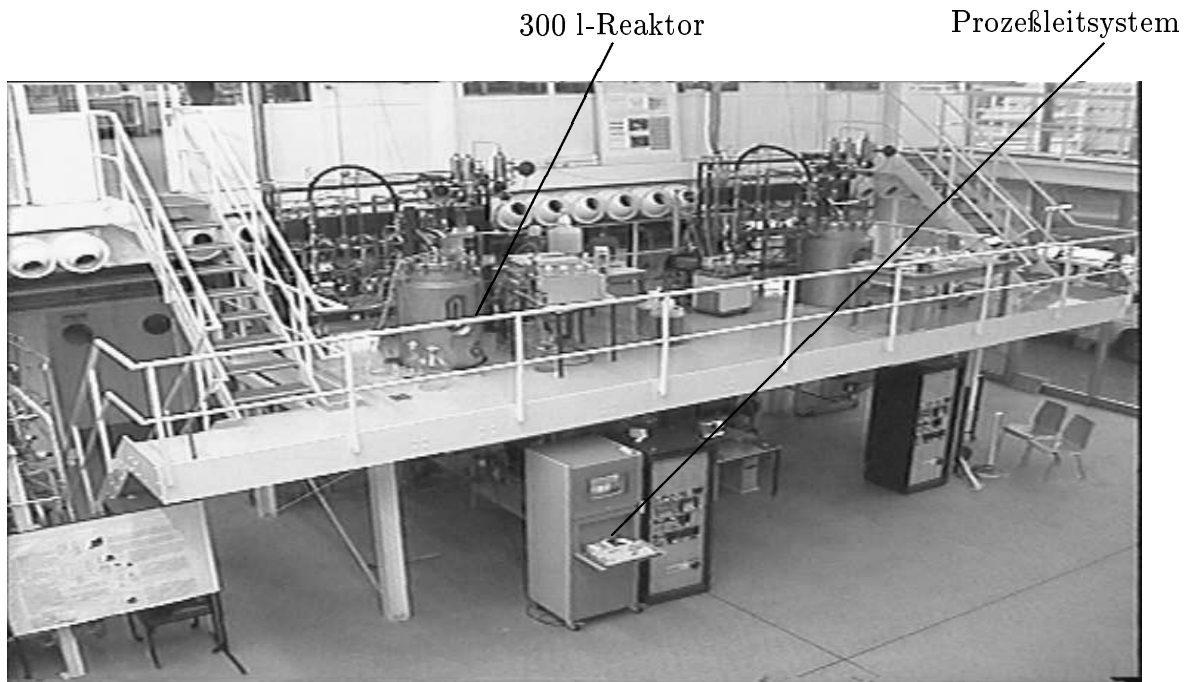
Bild 5.1: Bioverfahrenstechnischer Reaktor zur Penicillinherstellung am Institut für Bioverfahrenstechnik der Universität Stuttgart.
