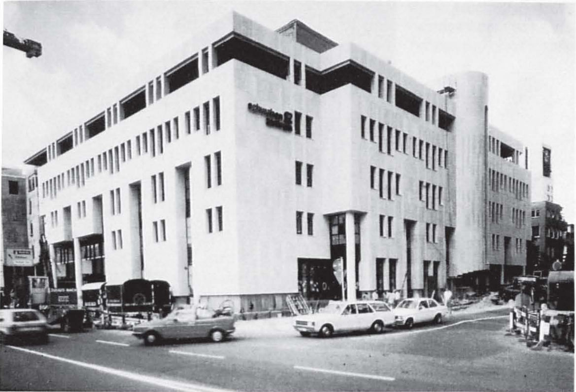
Bild 5: Beispiel einer Fassade – Schwabenzentrum in Stuttgart
