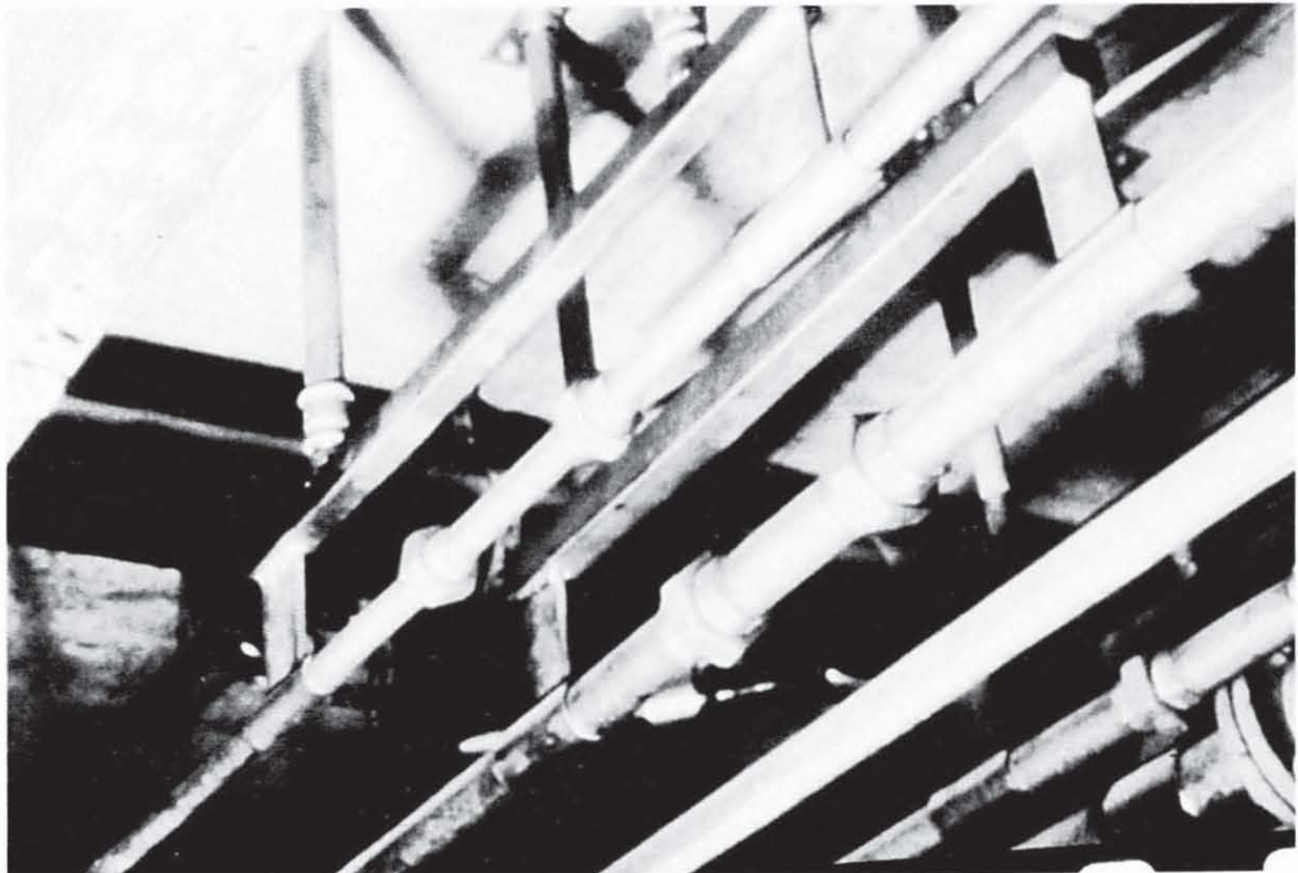
Bild 10: Abgehängte Rohrleitungen
