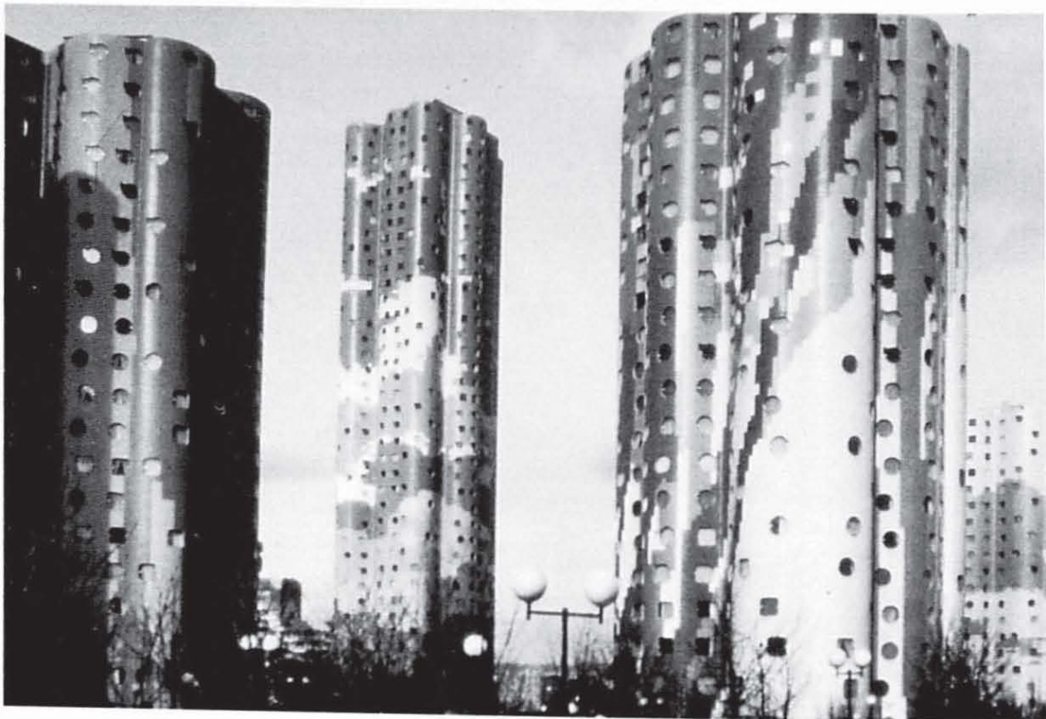
Bild 4: Beispiel einer Fassade – La Défense (Paris)
