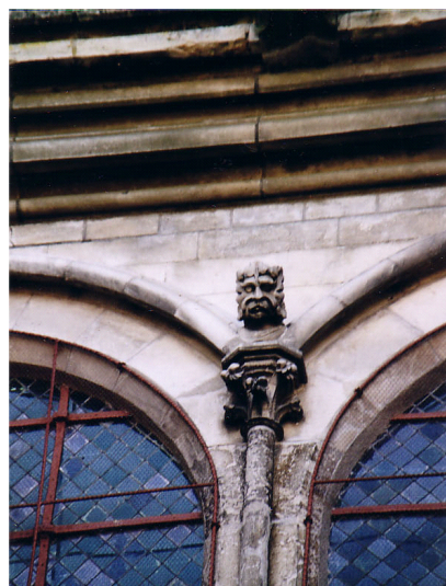
27. Détail des baies 31/33
