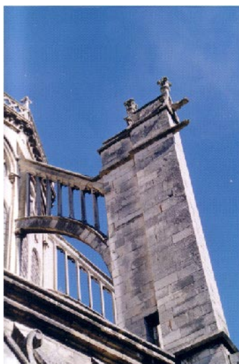
22. Vue du 9 e contrefort avec arc-boutant
