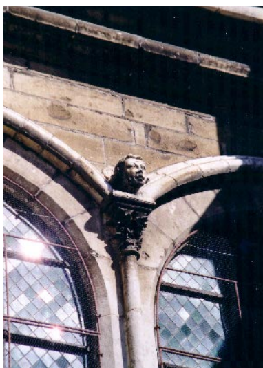
26. Détail des baies 32/34
